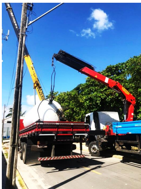
Troca do tanque de oxigênio com capacidade de atendimento para atender 80 leitos UTI
