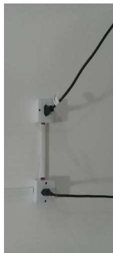
Instalação de tomada na sala da tomografia
