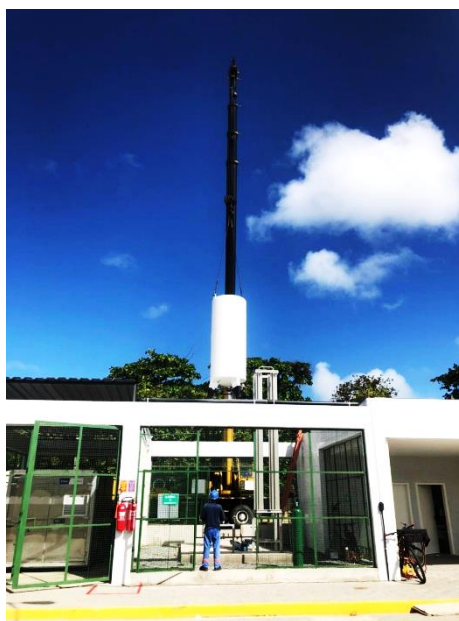
Troca do tanque de oxigênio com capacidade de atendimento para atender 80 leitos UTI
