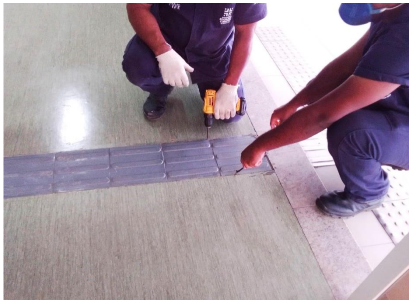
Instalação do novo piso tátil das recepções
