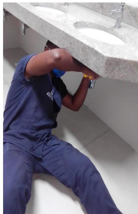
Reparo no lavatório do WC Social
