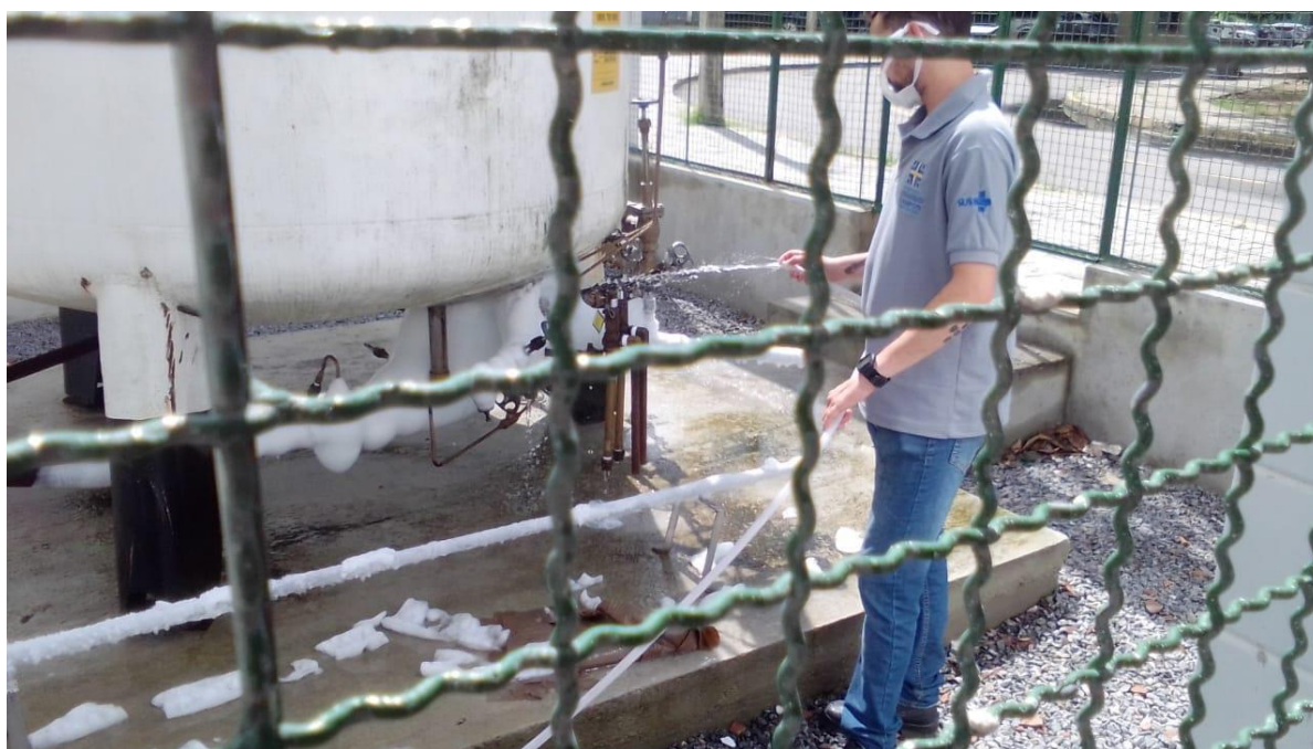
Descongelamento do tanque de oxigênio
