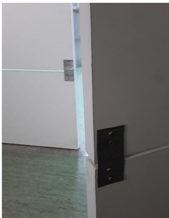
Instalação da chapa de aço
