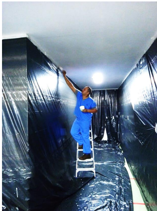
Depois – Teto Bloco Cirúrgico
