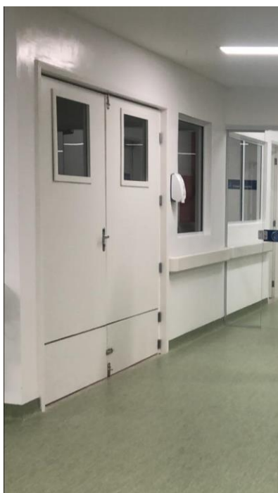
Antes da adequação
