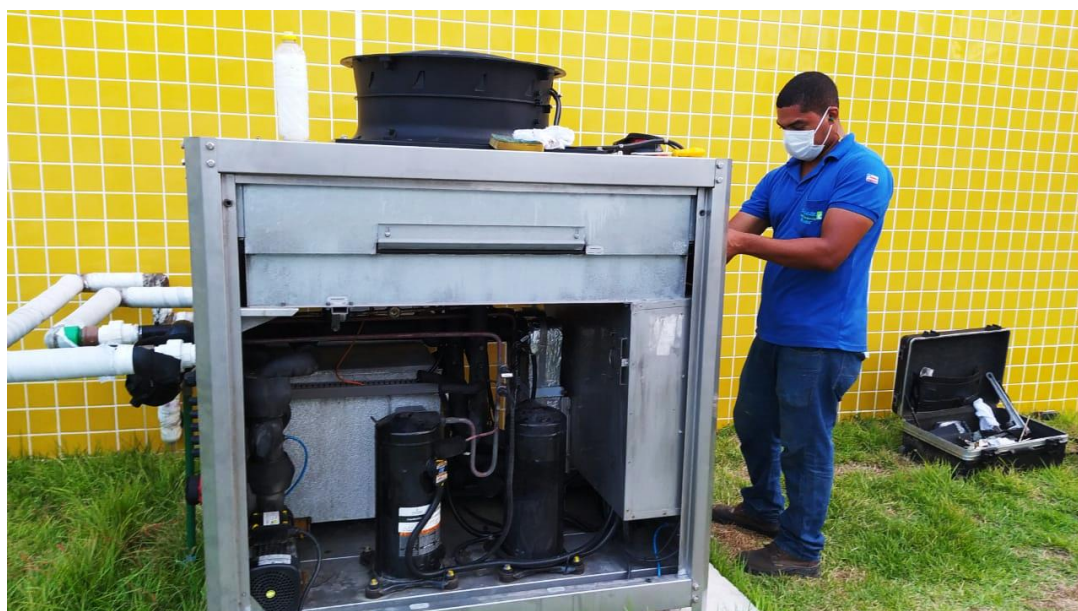
Instalação da tubulação do Chiller
