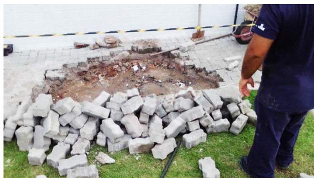
Reparo do piso da Calçada - Antes
