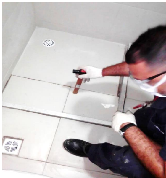
Instalação de divibox
